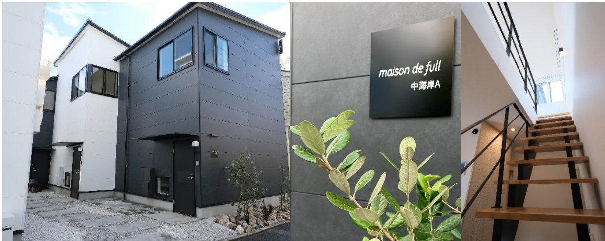
※maison de full 中海岸 A・B棟 完成写真（2024/11/9撮影）
